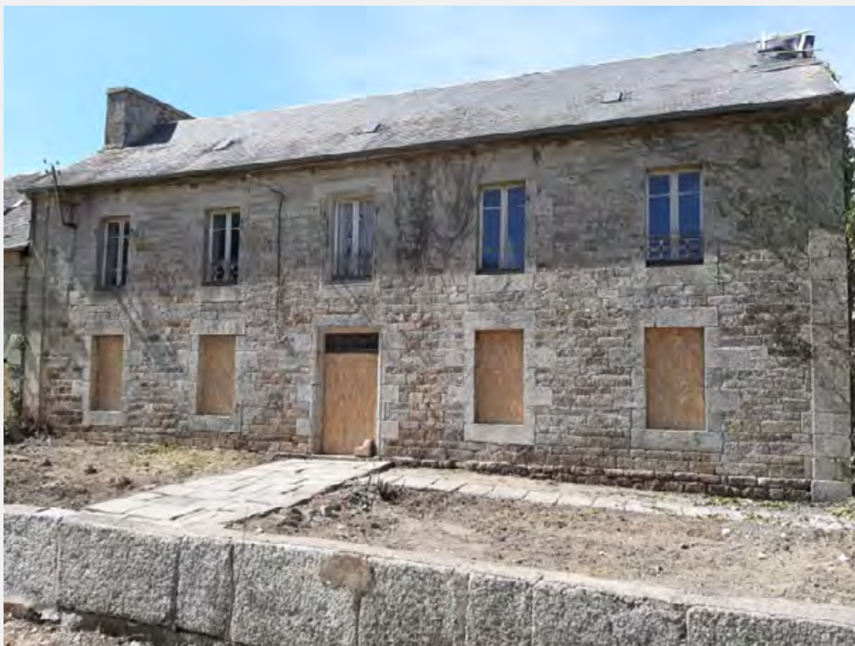
Rénovation d'un bâtiment ancien en éco construction et aménagement d'un centre d'interprétation et salle de séminaire.
